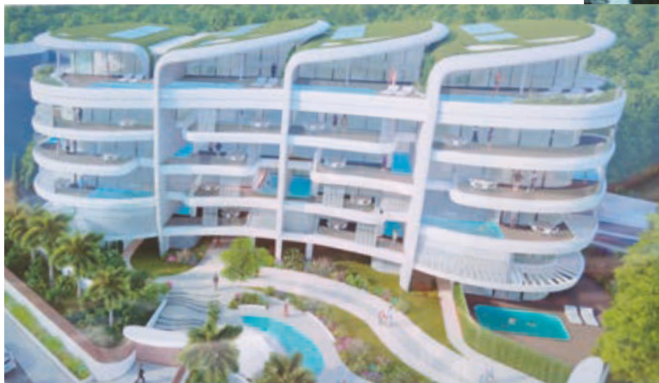
Το project της X. Κανελλάκης Α.Ε. σε οικόπεδο πάνω στη λεωφόρο Ποσειδώνος. Πρόκειται για «συγκρότημα πολυτελών διαμερισμάτων με υπαίθριες πισίνες», την κατασκευή του οποίου έχει αναλάβει η ΤΕΡΝΑ Α.Ε.
